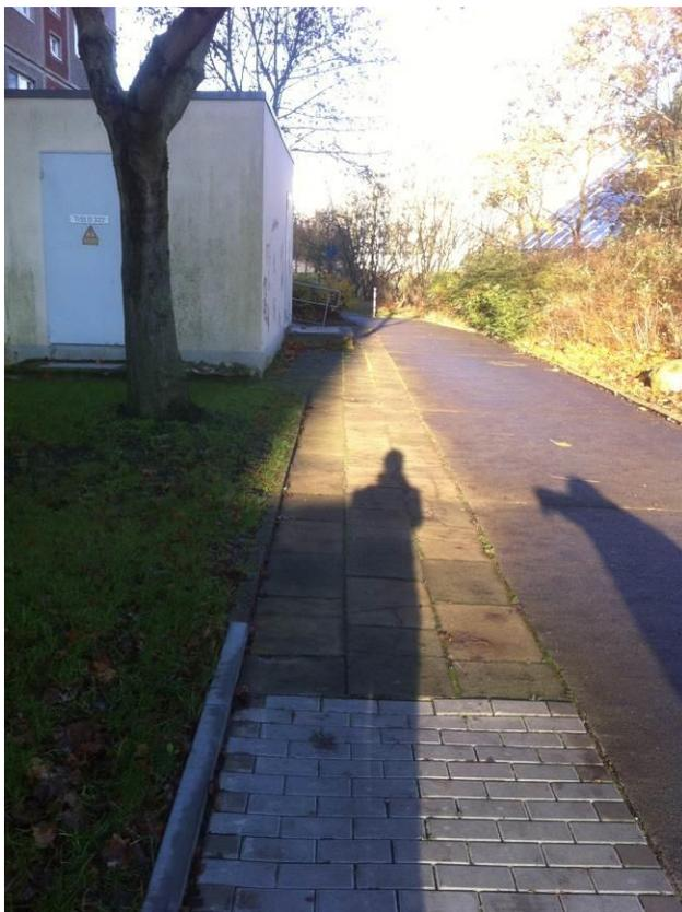
Abb. 6 Ziolkowskistraße 18/19, Vorhandener Weg aus Betonsteinplatten und Betonpflaster zwischen den beiden Häusern.
