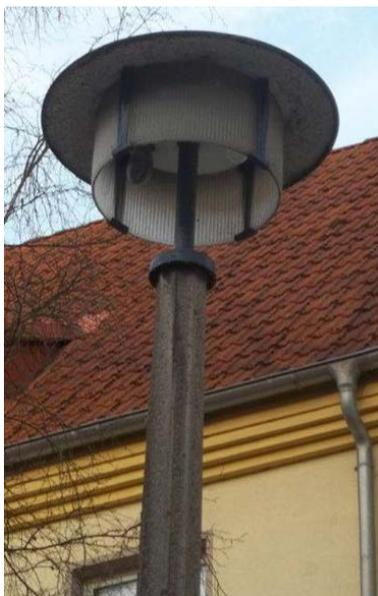
LED-Leuchte auf Stahlbetonmast 6m ohne Ausleger (Ersatz für RSL-Leuchte)
