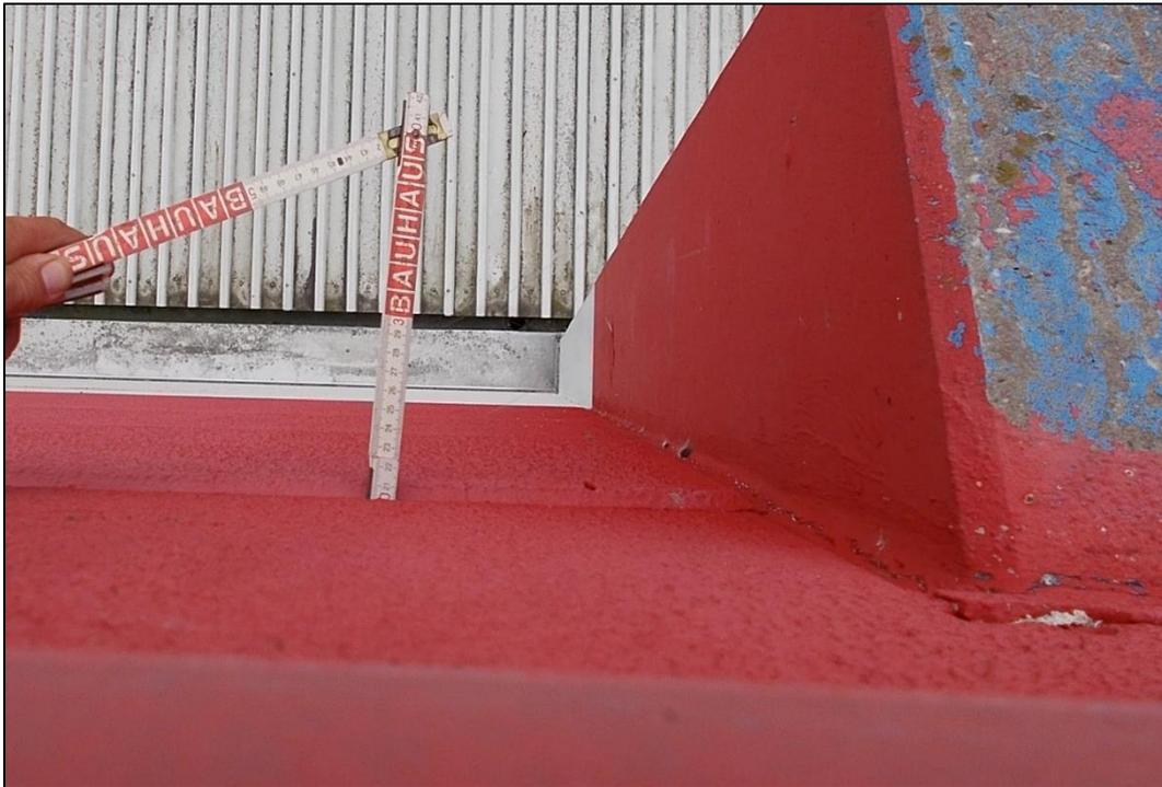
Abbildung 6: Ansicht eines 20 cm tiefen Spalts (ein Zollstockglied) im Bereich der Fassadenpfosten.
