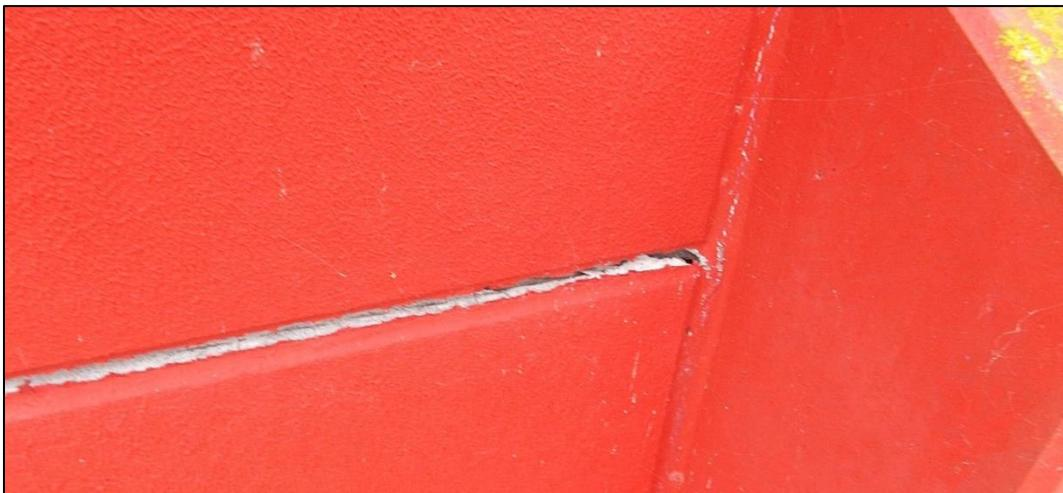
Abbildung 5: Ansicht auf einen der tieferen Spalten nahe dem Fassadenpfosten.
