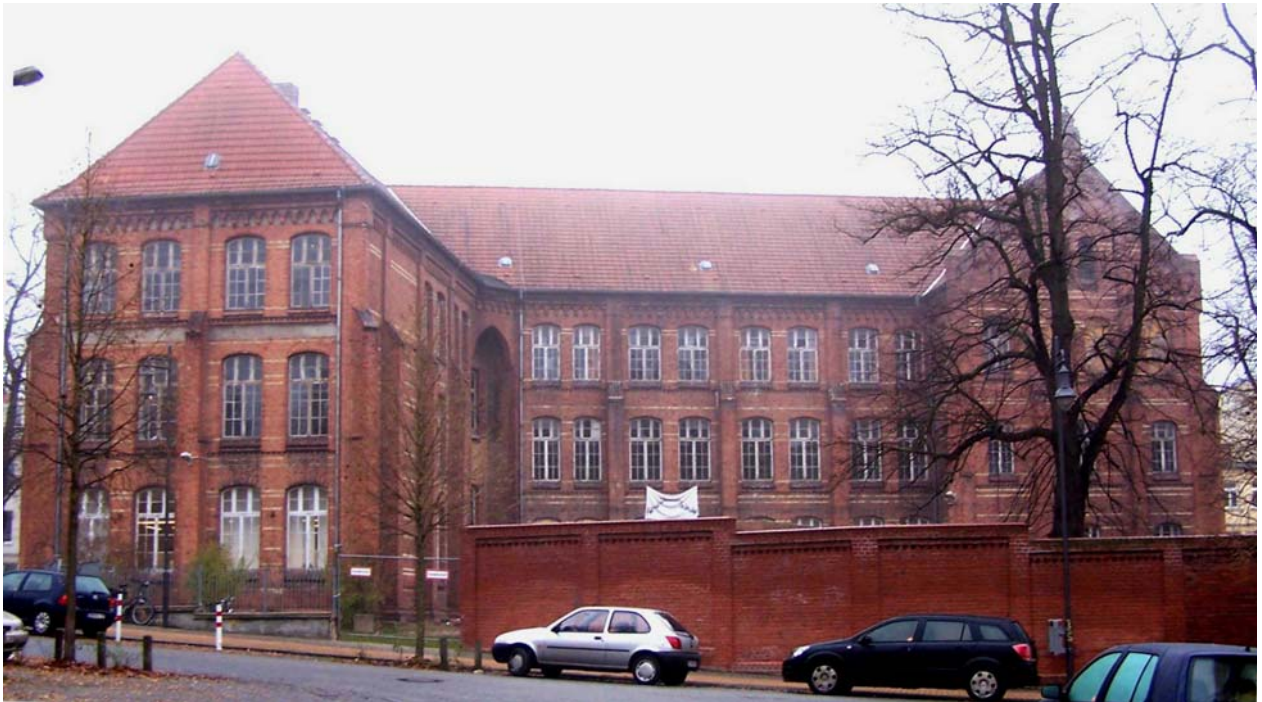
Hofseite (Blick von Süden)
