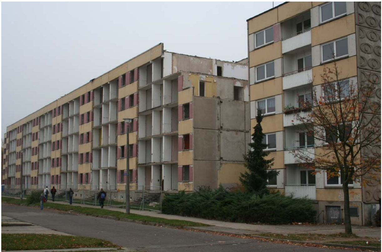
Gebäudebestand bei Abrissbeginn
